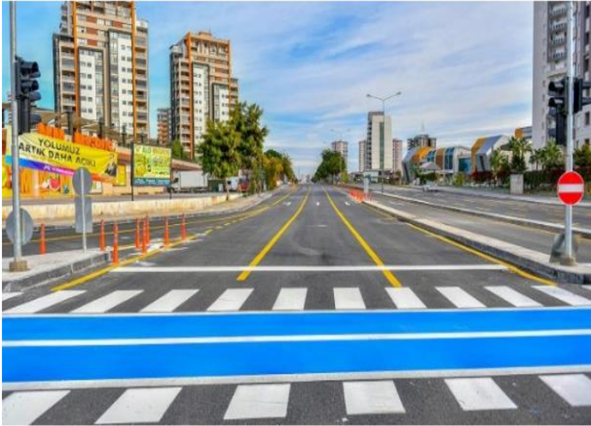
İKİNCİ KANALİZE KAVŞAK ÇALIŞMASI TAMAMLANDI
