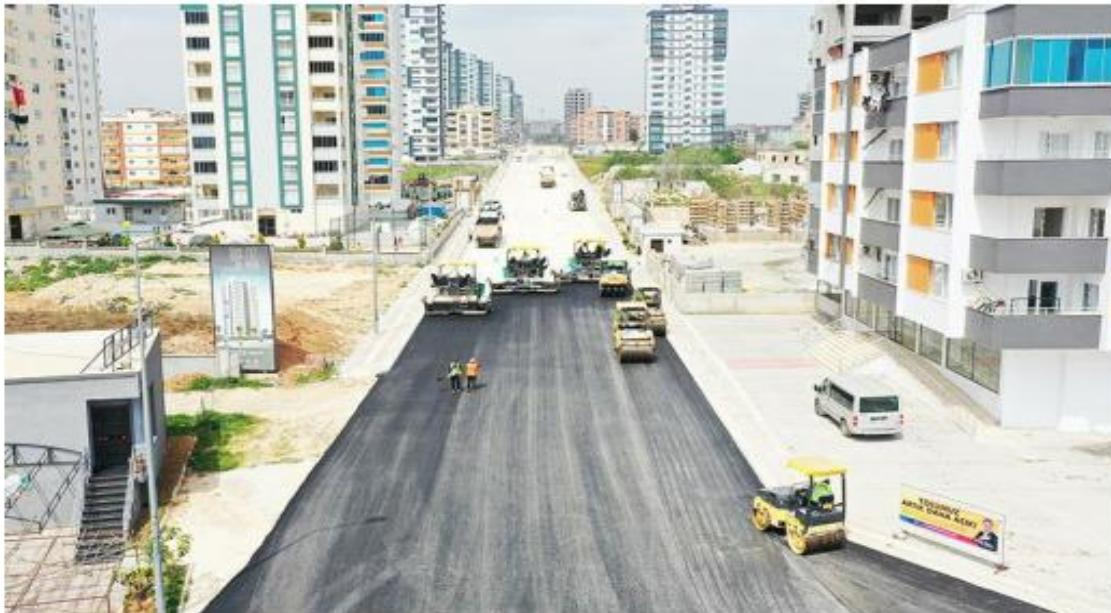
Kent genelinde cadde, bulvar ve grup yollarında bakım ve iyileştirme çalışması yürüten Mersin Büyükşehir Belediyesi Yol Yapım Bakım ve Onarım Dairesi ekipleri, yeni yerleşim bölgelerindeki yol ve kaldırımlarda da düzenleme ve yağmur suyu tahliye sistemi döşeme çalışması gerçekleştiriyor.
