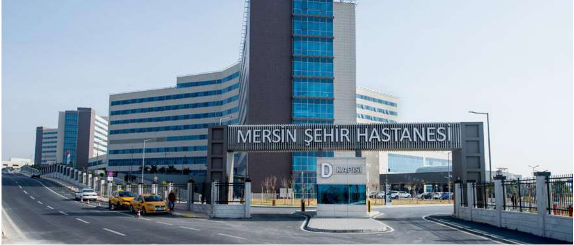
Fotoğraf 16. Şehir Hastanesi İstasyonu Yeri
